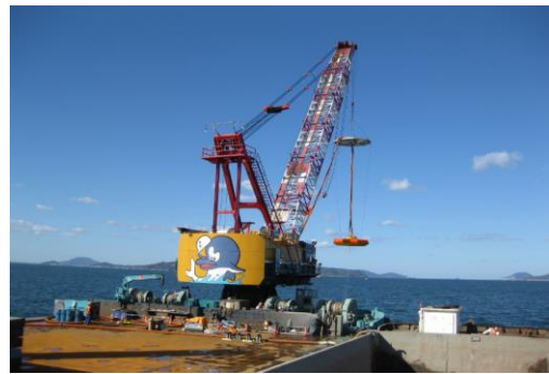
図 5 博多港での施工状況
