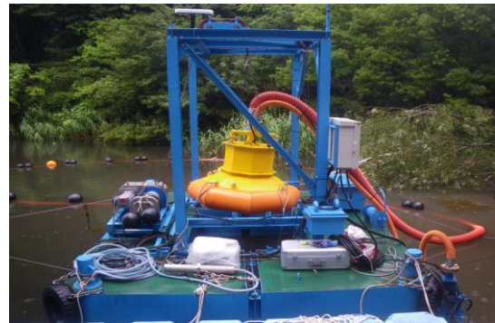
図 7 ため池での施工状況
