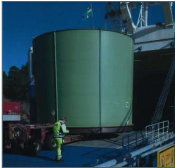
図1 Oskarshamn 1の使用済蒸気乾燥器の輸送状況
