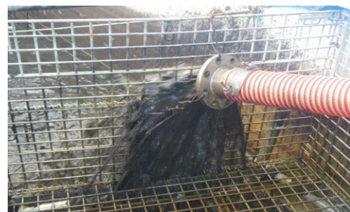
図 8 ため池での施工状況
